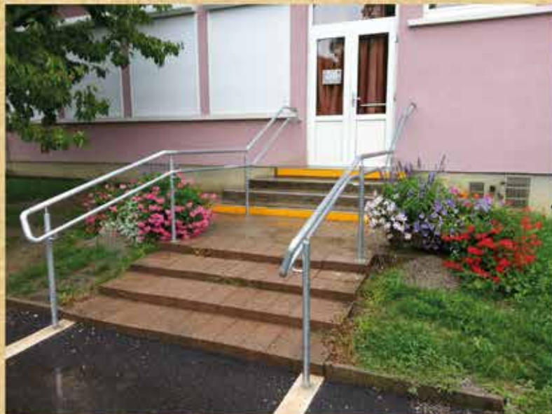
Dans le cadre de la mise en accessibilité une rampe a été posée dans les escaliers de l'école maternelle
