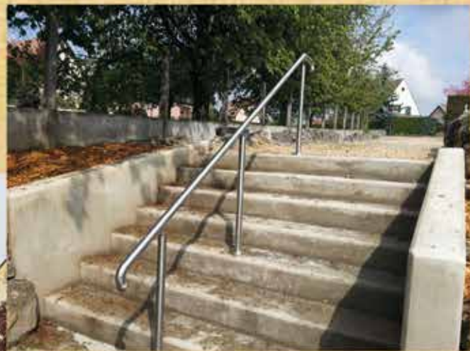
Une rampe pour la descente d'escaliers au terrain de jeux
