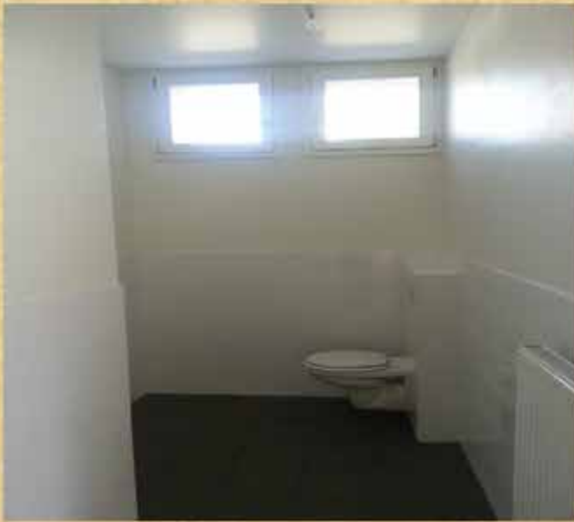
Aménagement d'un WC handicapé en classe primaire.
